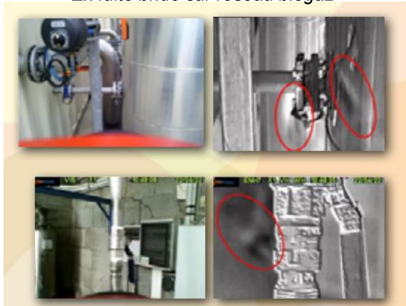
Fuite raccord fileté du flexible d'arrivée avant module cogé
