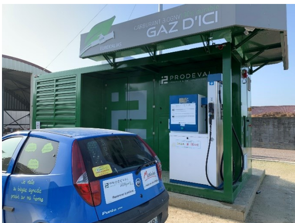
Figure 2 : Exemple de station AgriGNV® au format container
