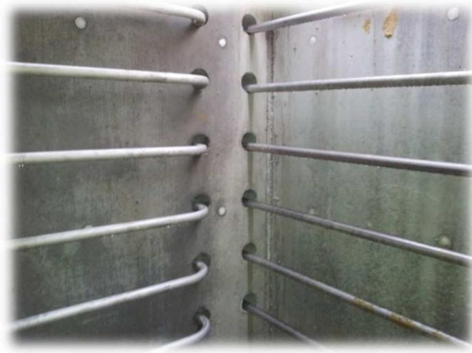
Figure 20 : Système de chauffage serpentin INOX (source : Biogaz ingénierie)
