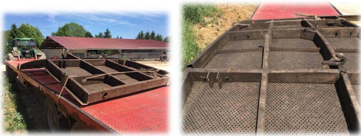
**Figure 30 : Photo d'une pré-porte de garage ayant cédé sous le poids du percolât** (source : Biogaz ingénierie)
