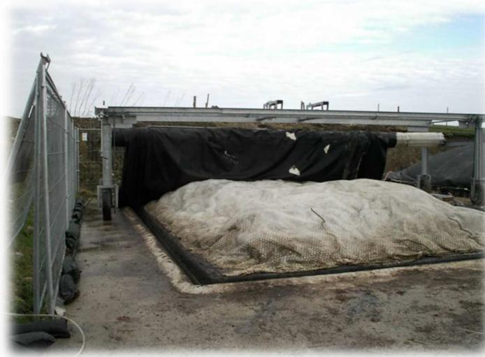
Figure 18: Isolation d'un digesteur en silo bâché sous le gazomètre (source : Biogaz ingénierie)
