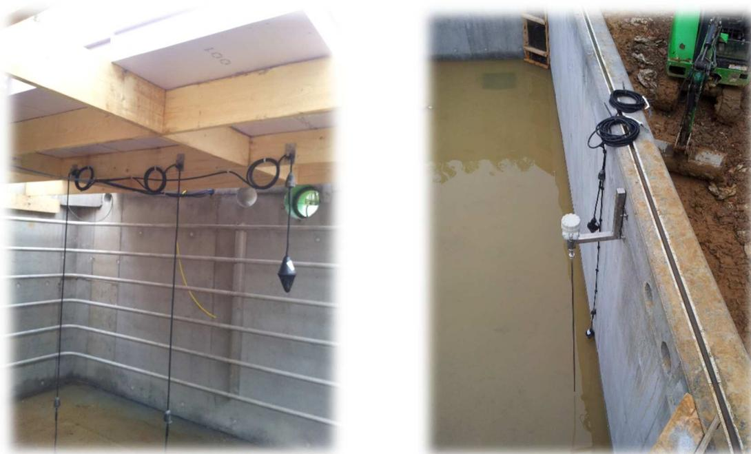
Figure 22 : Photographies de capteurs TOR type "poires de niveau" (source : Biogaz ingénierie)
