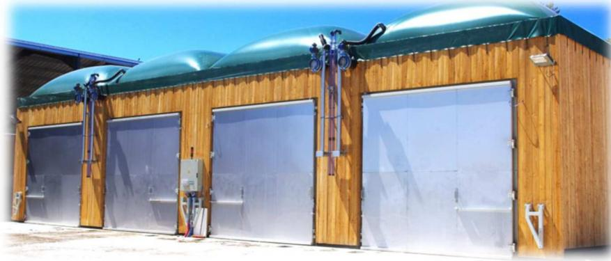
Figure 4 : Installation en voie sèche discontinue, concept garages (Source : Installation Naskéo Méthajade en Côte d'Or)
