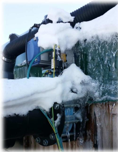
Figure 27: Photographie d'une vanne prise dans le gel (source : Biogaz ingénierie)
