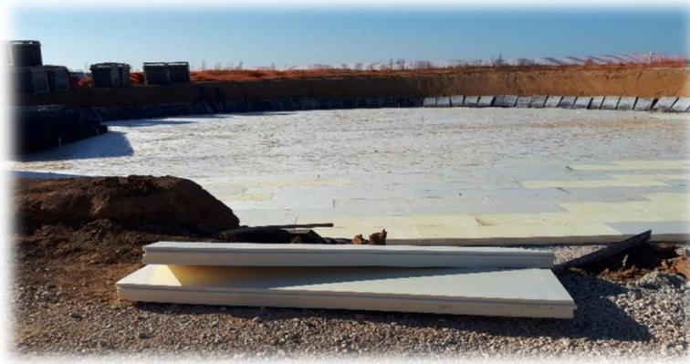
Figure 17 : Plaques de Styrodur® placées sous le radier d'une cuve de digestion (voie liquide) (source : Biogaz ingénierie)
