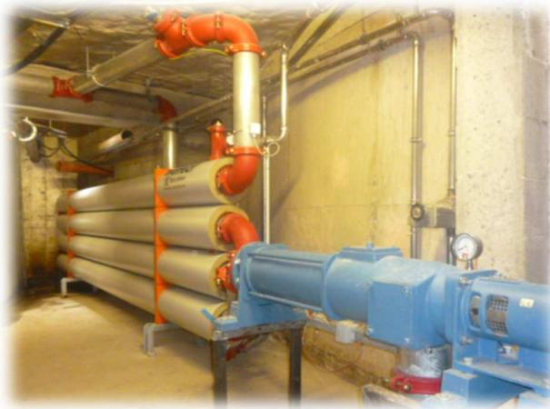
Figure 21 : Réchauffeur externe (source : Biogaz ingénierie)
