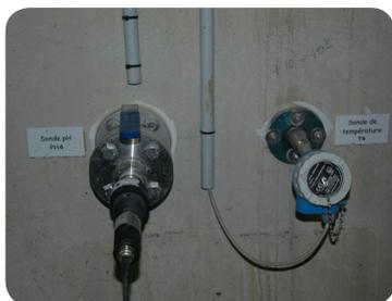
Figure 4 : Analyse de la température et du pH dans le digesteur
