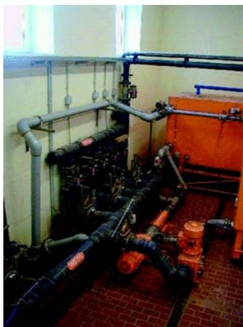
Figure 3.11 : Pompes dans une centrale de valorisation du biogaz [WELtec BioPower GmbH]
