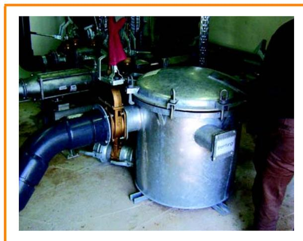
Figure 3.5 : Séparateur pour effluents chargés intégré à la canalisation [DBFZ]
