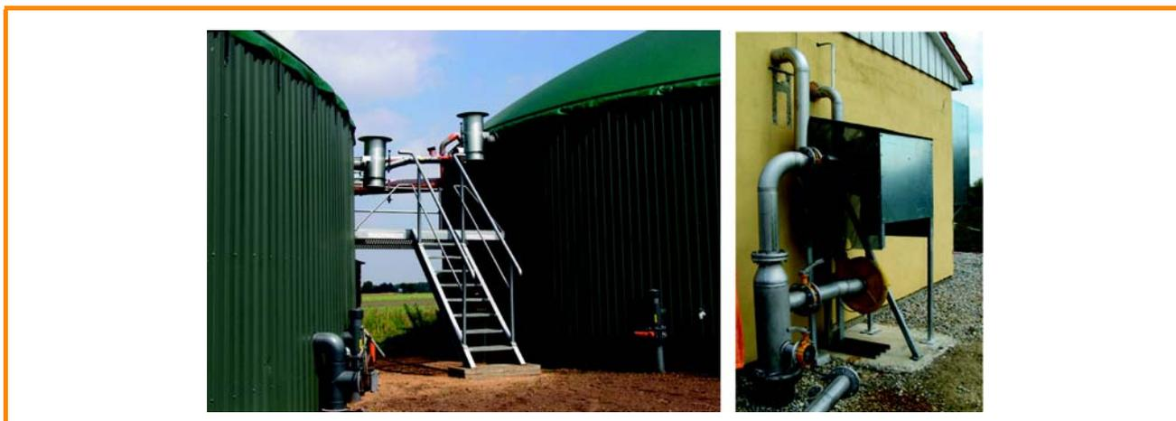
Figure 3.21 : Plate-forme de travail entre deux réservoirs avec canalisations et dispositif de décompression (à gauche), canalisations de gaz avec ventilateur compresseur (à droite) [MT-Energie GmbH (à gauche), DBFZ (à droite)]
