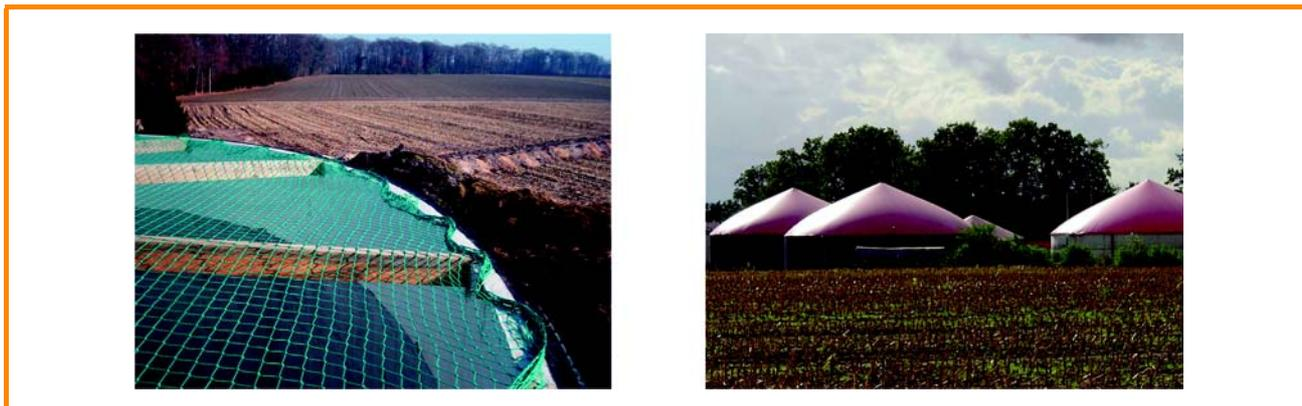
Figure 3.39 : Structure supportant un toit flottant (à gauche) ; centrales de valorisation du biogaz avec réservoirs à toit flottant [MT-Energie GmbH]
