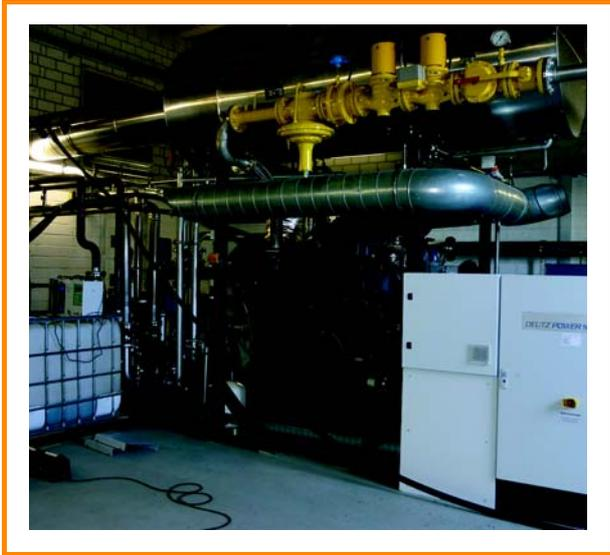
Figure 6.8 : Unité de cogénération avec système de régulation du gaz [DBFZ]
