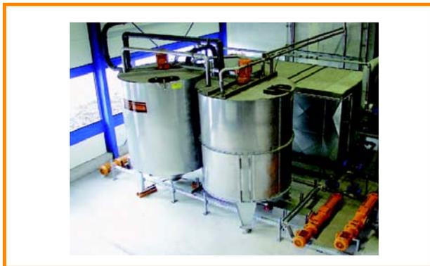
Figure 3.10 : Hygiénisation avec refroidissement [TEWE Elektronik GmbH & Co. KG]
