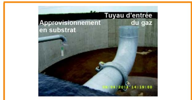
Figure 3.36 : Disposition permettant d'éviter toute perturbation dans l'extraction du gaz ; tuyau d'entrée du gaz avec ouverture vers le haut (tuyau d'entrée du substrat à gauche) [DBFZ]
