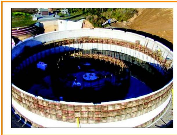
Figure 3.29 : Digester en béton en cours de construction [Johann Wolf GmbH & Co Systembau KG]
