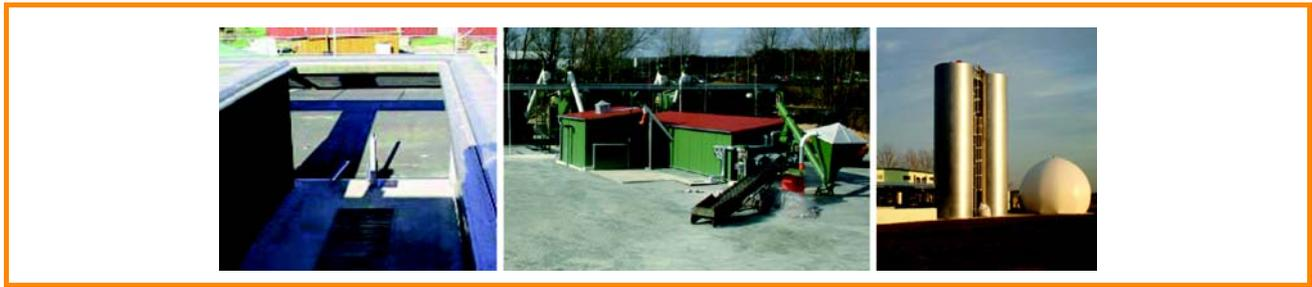
Figure 3.28 : Exemples de constructions spéciales pour la fermentation sèche ; réacteur biologique séquentiel (à gauche), réacteur de type garage avec agitateur (au milieu), étape de méthanisation du procédé de fermentation humide/sèche et réservoir externe pour le stockage du gaz (à droite) [ATB Potsdam (à gauche), Mineralit GmbH (au milieu), GICON GmbH (à droite)]
