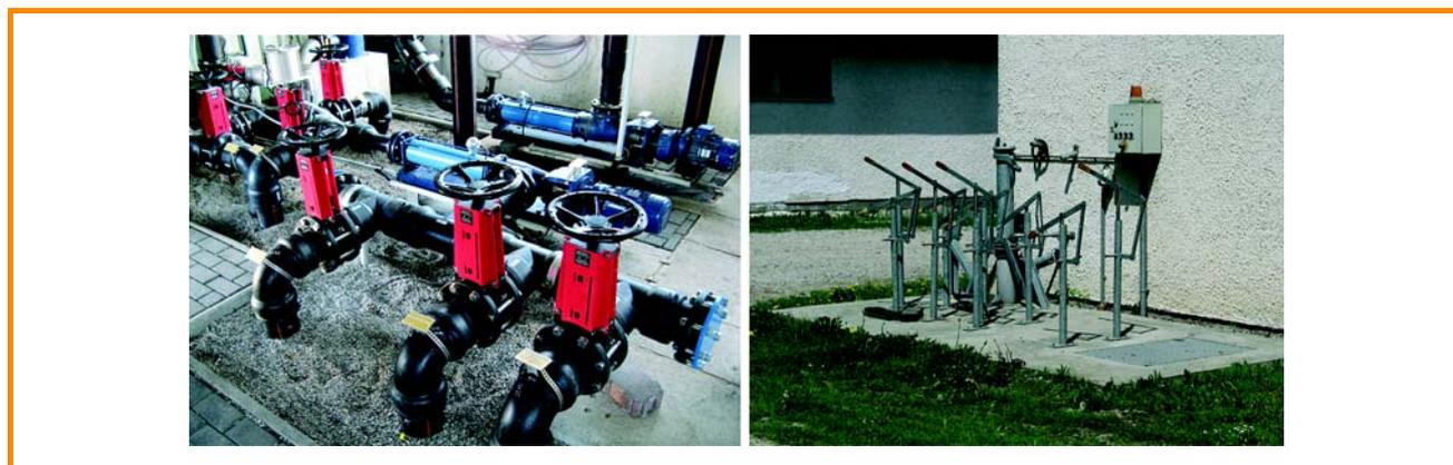
Figure 3.20 : Canalisations, robinets et raccords dans une station de pompage, robinets d'arrêt [DBFZ]
