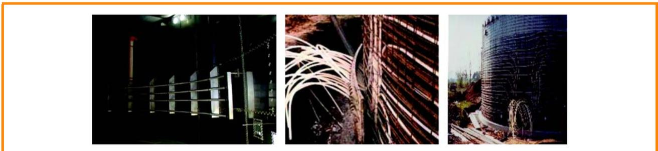
Figure 3.37 : Tuyaux de chauffage en acier inoxydable installés dans le digesteur (à l'intérieur) (à gauche) ; installation de tuyaux de chauffage dans la paroi du digesteur (à droite) [Biogas Nord GmbH ; PlanET Biogastechnik GmbH (à droite)]
