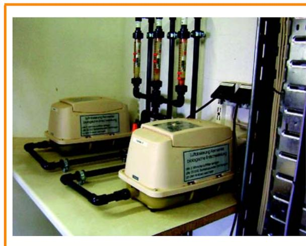
Figure 6.1 : Système de contrôle du gaz pour l'injection d'air dans l'espace réservé au gaz du digesteur [DBFZ]
