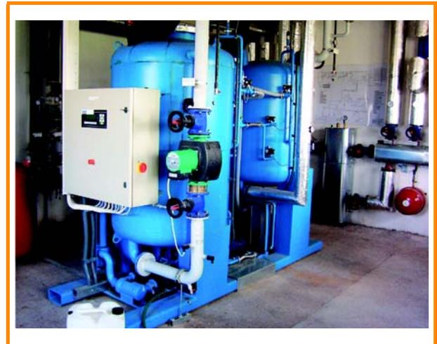
Figure 6.14 : Exemple de réfrigérateur à absorption dans une centrale de valorisation du biogaz [DBFZ]
