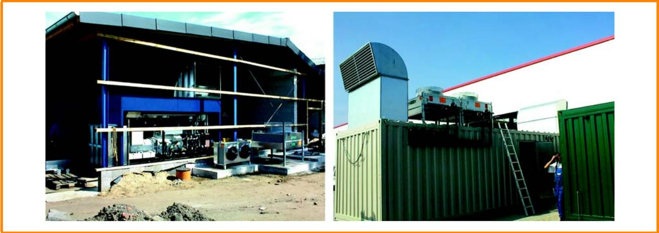
Figure 6.9 : Installation d'une unité de cogénération dans un bâtiment et dans un conteneur spécialement conçu à cet effet [Seva Energie AG]
