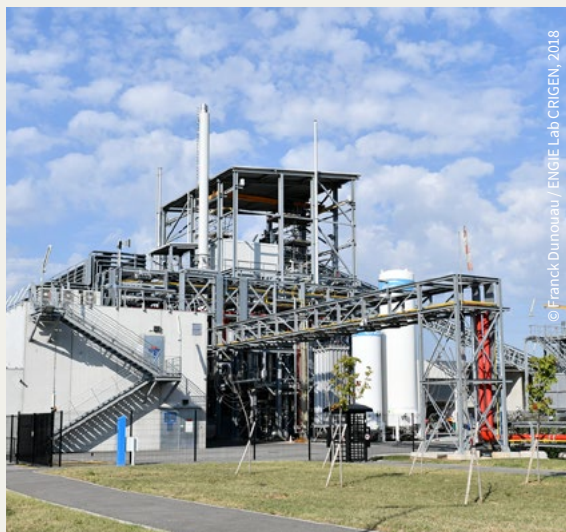
Plateforme du projet Gaya
