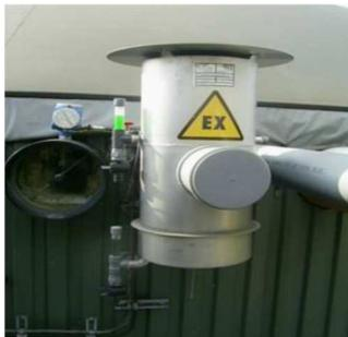
Des soupapes de sécurité doivent être mises en place sur le digesteur (post-digesteur) et le stockage du biogaz pour prévenir les surpressions ou les sous-pressions susceptibles d'entraîner un risque pour la sécurité.
