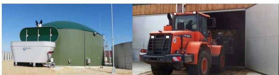
Image 3 – Différentes façons d'incorporer des intrants solides dans le digesteur (à gauche : trémie d'incorporation [source WELTEC BIOPOWER] ; à droite : chargement d'un digesteur de type garage [source : Methajade])
