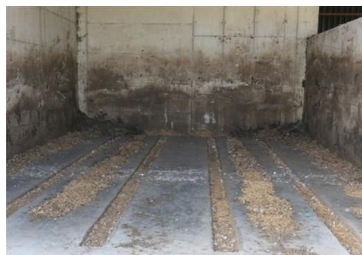
Dispositif d'aération forcée intégré dans la plate-forme de compostage.
