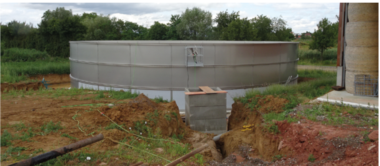
Réservoir semi-enterré de stockage de digestat
