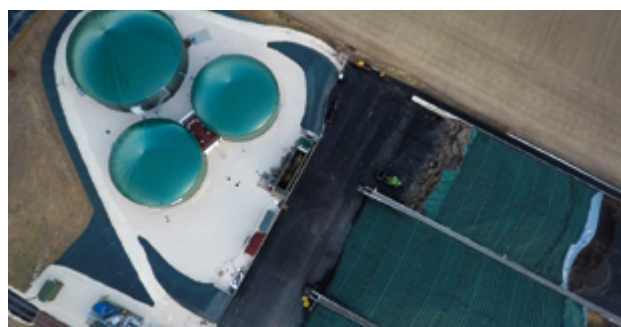
Vue du ciel d'une unité de méthanisation agricole
